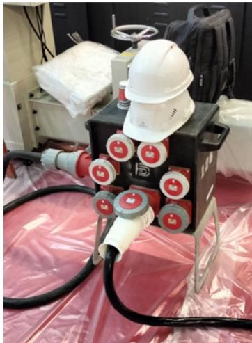
Удлинитель на одном из стендов. Максимальное энергопотребление стенда — 200 кВт
